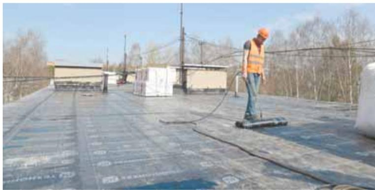
нием современных материалов. Таким образом выявляются основные зоны скопления воды, а после демонтажа существующего кровельного ковра выравниваются уклоны.
