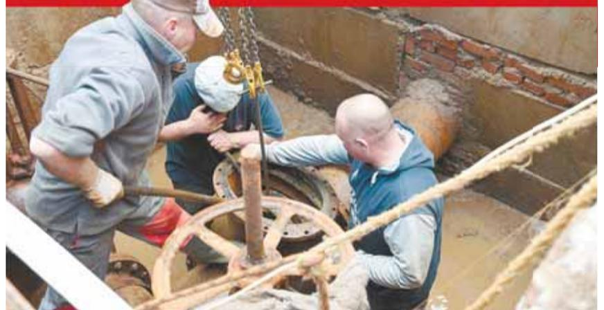
В Дмитрове на одном из участков магистрального трубопровода диаметром 400 мм полностью выработала свой ресурс и вышла из строя запорная арматура (шток и запорный парный элемент, так называемые щечки), отвечающая за открытие и закрытие потока воды.
