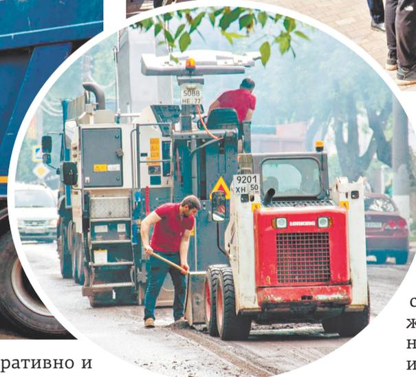
Кроме капитального, в Подольске ни на день не останавливается и ямочный ремонт дорог. «Рабочие коммунальных и дорожных служб выявляют дефекты асфальтобетонного покрытия, которые в течение трех суток устраняют, а также ремонтируют дорожное полотно вблизи сливов и канализационных люков», – сообщается на сайте администрации муниципалитета.
