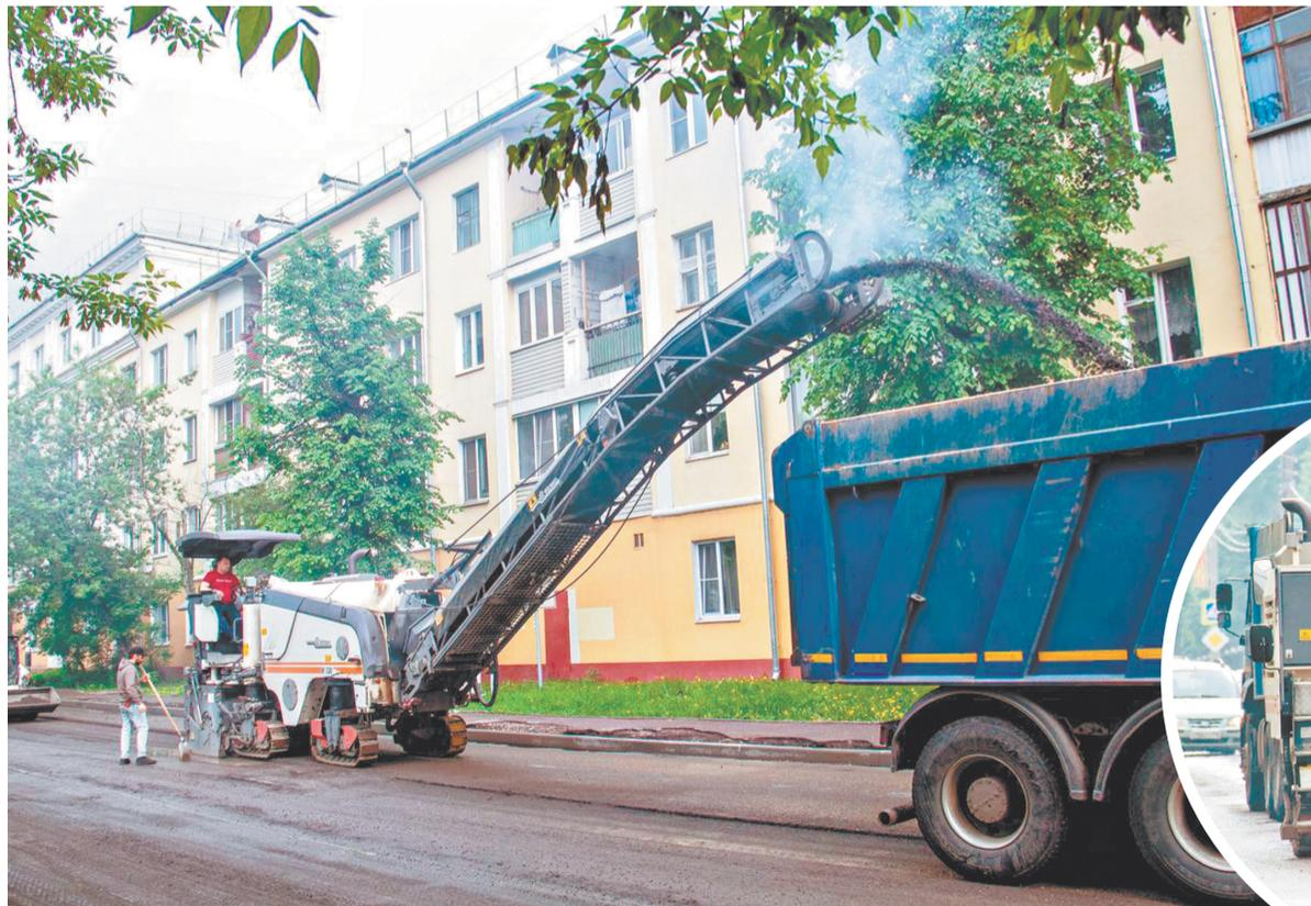
Так, на улице Рабочей на днях была завершена установка бордюрного камня и фрезеровка старого покрытия. Все работы, в том числе и укладка нового асфальтобетона, должны были быть выполнены ровно за неделю.
